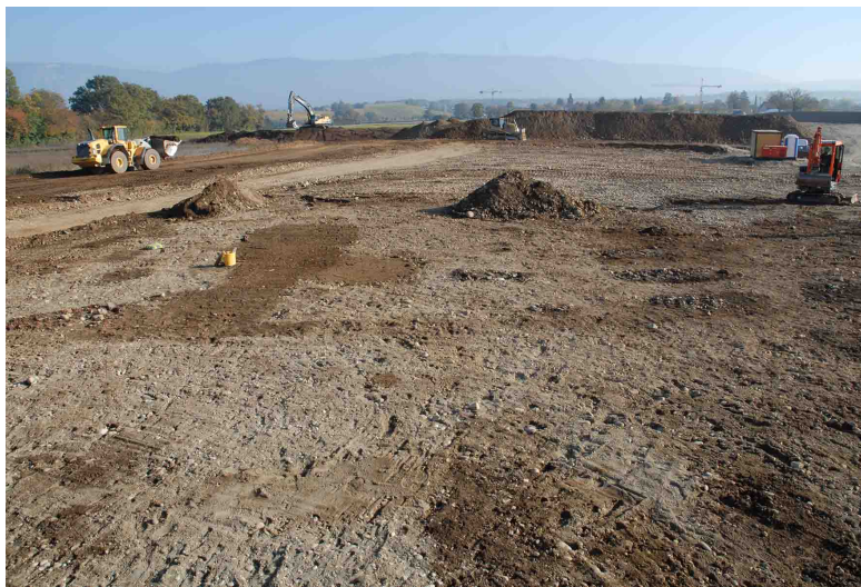
Vue du chantier de Laconnex
